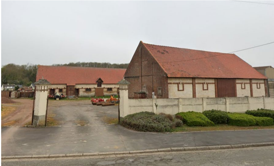
Bâti remarquable (corps de ferme) rue Pasteur
